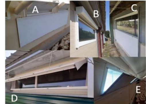
Différents types d'occultants : plaque occultante (A), volet roulant (B), guillotine (C), charnière (D), intégré à la trappe d'air (E)
